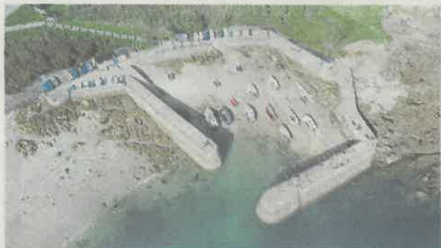
→ Toute la tranquillité de port Racine séduit, à marée haute comme à marée basse.
